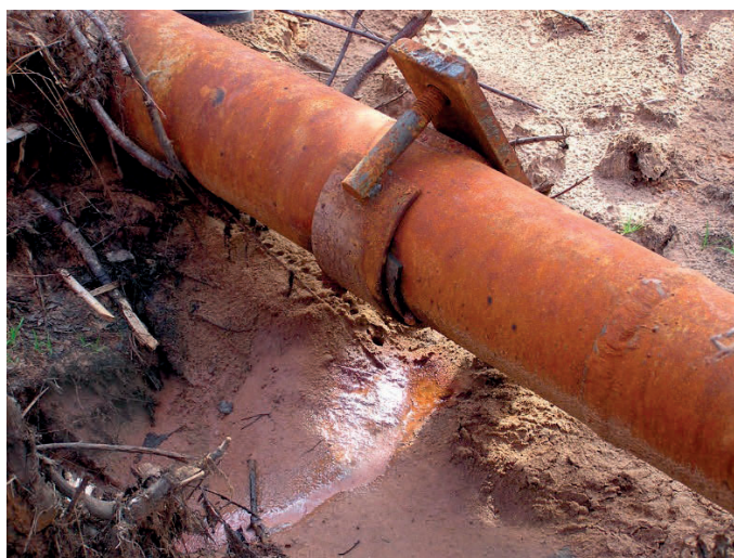
Фото 3.3. «Хомут» для герметизации аварийного трубопровода на нефтяном месторождении
